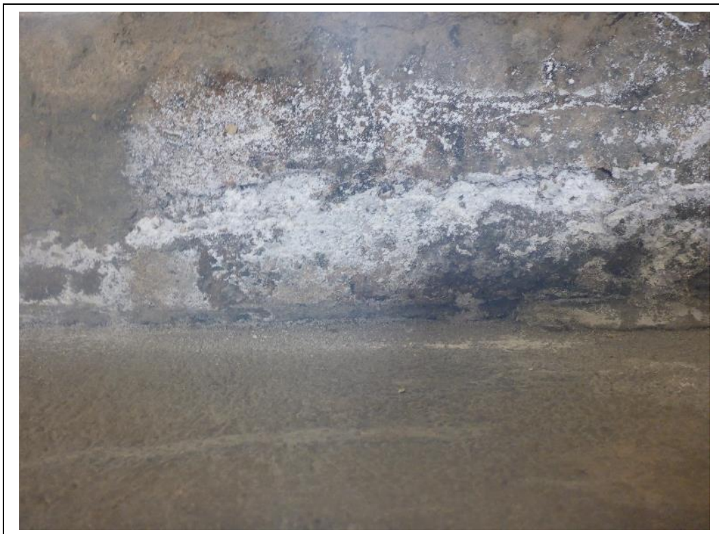
Abb. 15: Vst Leuna Werke Süd, PU km 19,287: Treppenaufgang zum Bahnsteig 2, Beton mit Salzausblühungen
